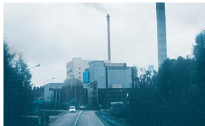
木屑を燃料にしている Sandvick コジェネレーション施設（暖房と電力をまちに供給する）
